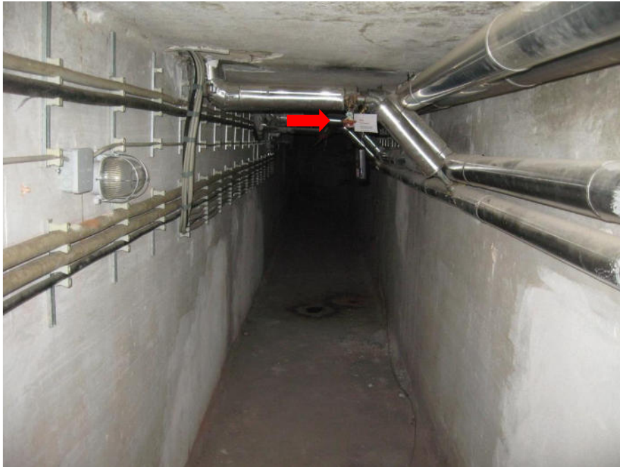
Abb. 1: Kellergang hinten, ca. 6m vor dem Gangende (keine Belüftung)
