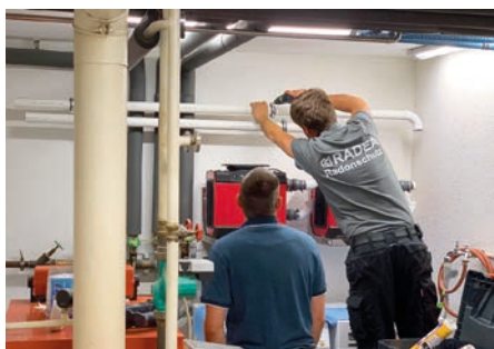
(2) Installation der Rohrleitungen für die Radon-Absaugung
