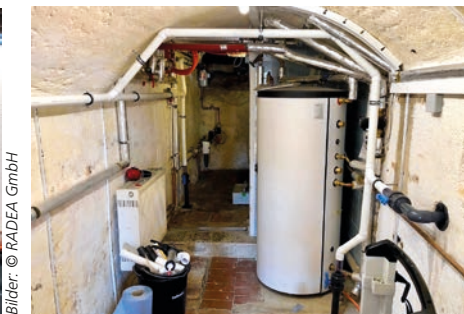
(3) Die Platzierung der Absaugpunkte ist wesentlich für den Erfolg der Radon-Reduzierung.
